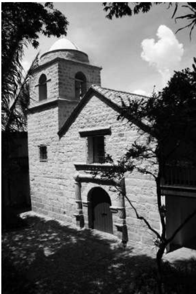
Figura 16. Fachada frontal de la capilla de Nuestra Señora del Rosario. La Calera. Foto: Roberto Lleras.
