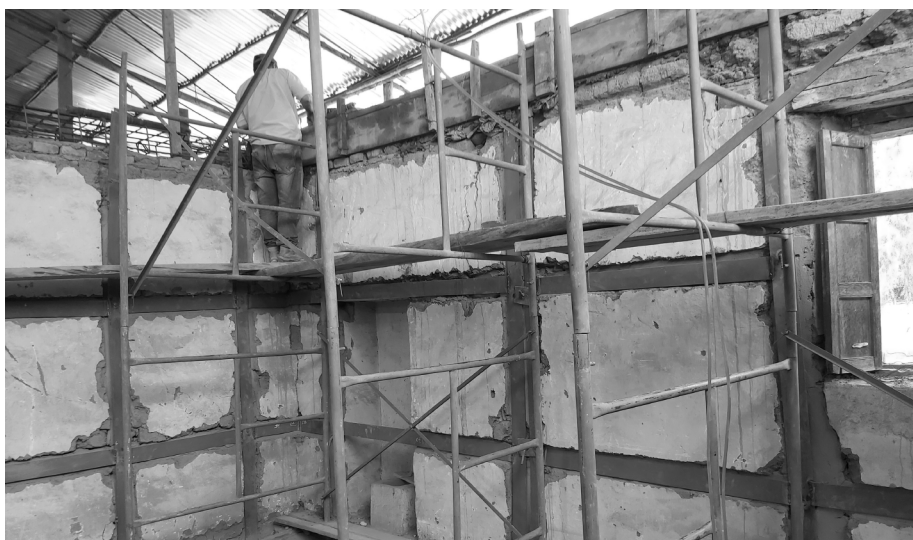
Figura 11. Aspecto de reforzamiento parte interna, empalme de viga corona. Fotografía del autor.
