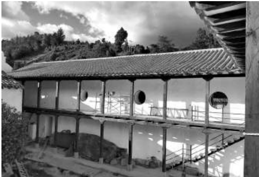
Figura 23. Aspecto del acabado, en el balcón interior. Fotografía del autor.
