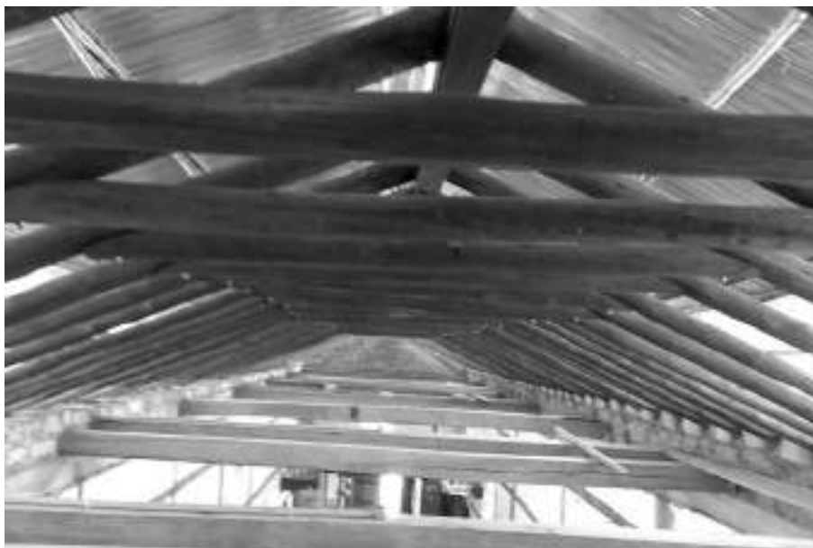
Figura 13. Aspecto de enmaderado de cubierta, devolviendo la forma interna de la capilla de 1670. Fotografía del autor.
