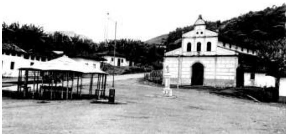
Figura 12. Para el traslado de Quiebralomo a Riosucio fue demolida la capilla y la comunidad que se negó a trasladarse construyó una nueva. (Archivo personal: Álvaro Gärtner).
