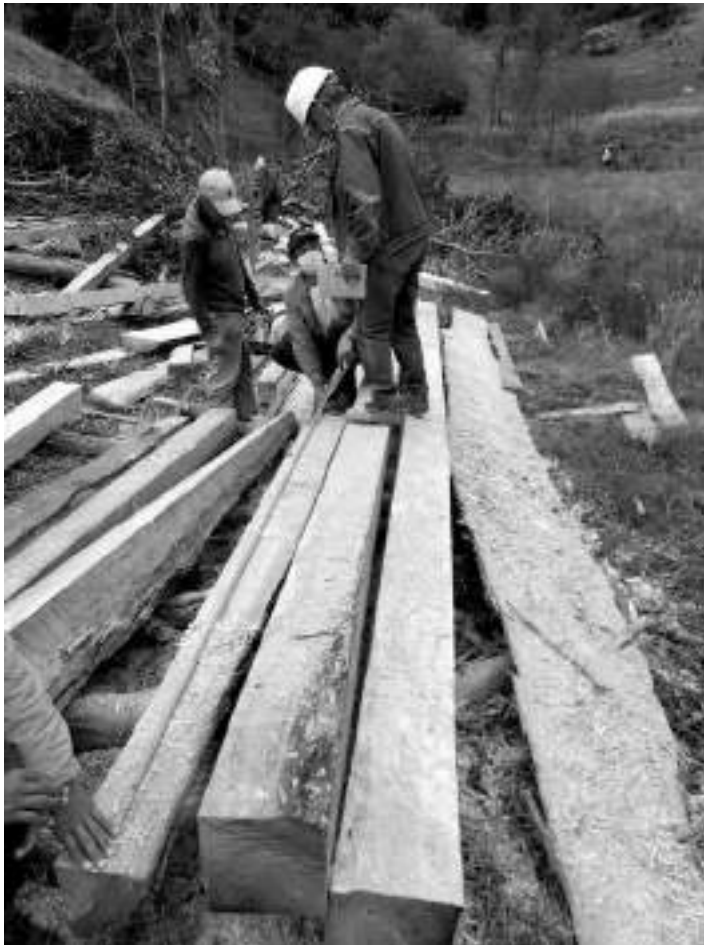
Figura 12. Alistado de madera donada por una familia, para tirante de cubierta. Fotografía del autor.
