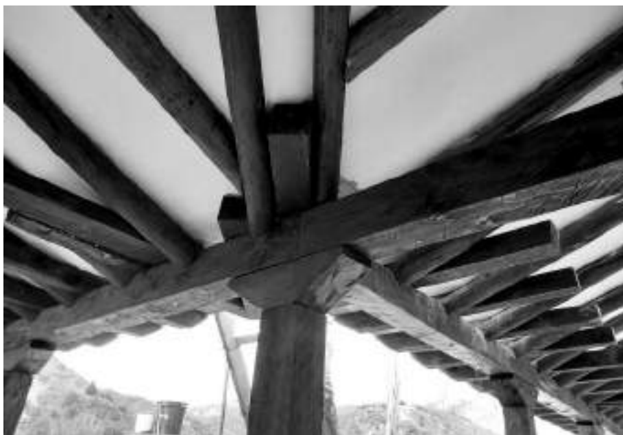
Figura 14. Recuperación de maderas, detalle de enmaderado en balcón posterior. Fotografía del autor.
