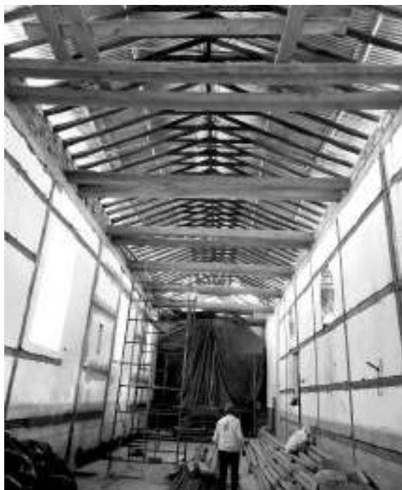
Figura 15. Aspecto de la cubierta recuperada en su composición original, enmaderado realizado por los maestros de los saberes de Otengá. Fotografía del autor.
