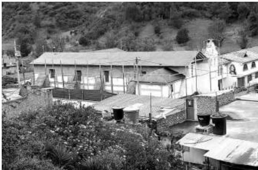
Figura 16. Aspecto de la cubierta restaurada, fase placa impermeabilizada. Fotografía del autor
