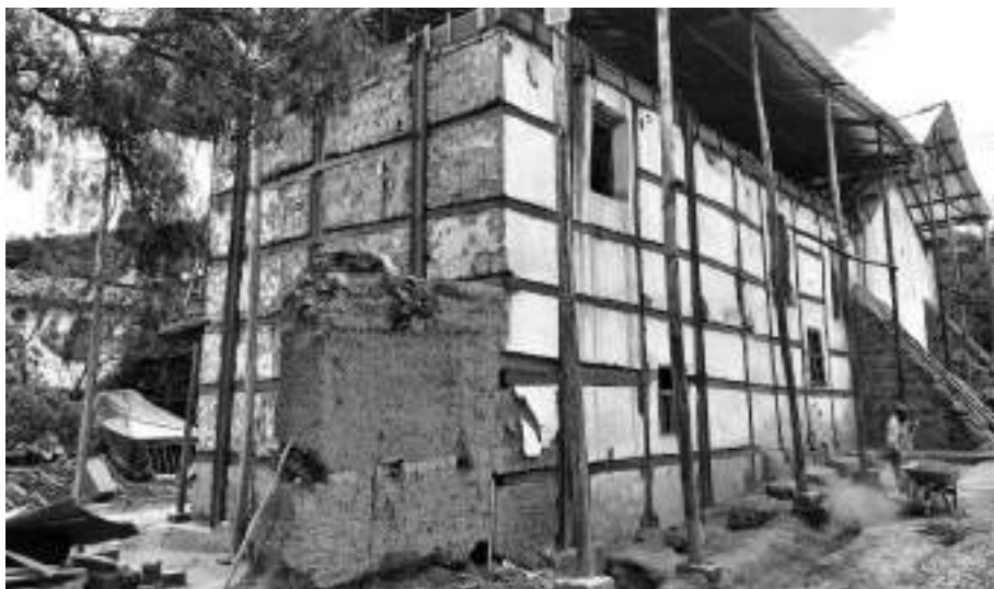
Figura 10. Obra de reforzamiento estructural, sector casa anexa (claustró). Fotografía del autor.
