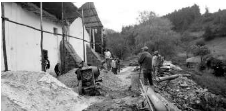
Figura 17. De la mano del maestro de la localidad, se realiza el convite, el día de fundir la viga de amarre. Fotografía del autor.
