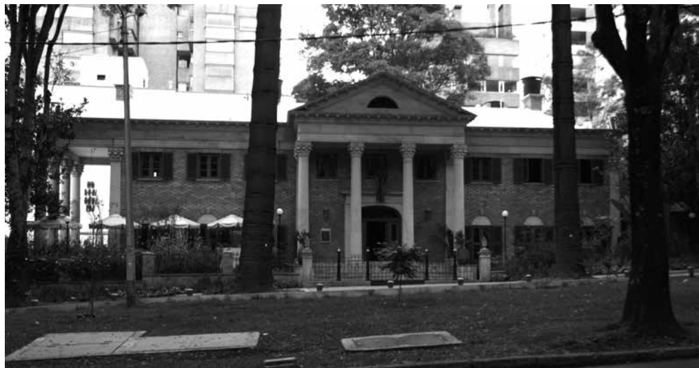
Figura 6. "[Fachada Mansión Planas]" Fotografía de la autora, Bogotá, 3 de noviembre de 2024.
